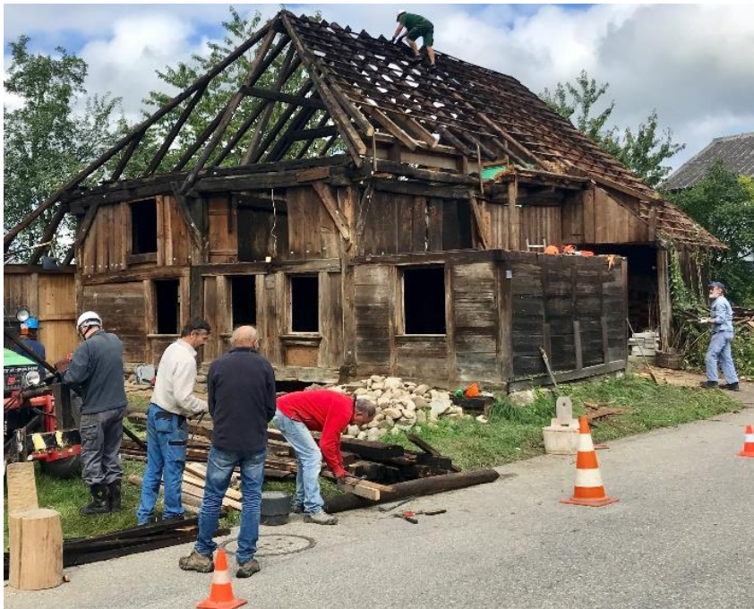
Holzhaus in Thunstetten während des Rückbaus / Démontage de la maison en bois à Thunstetten
