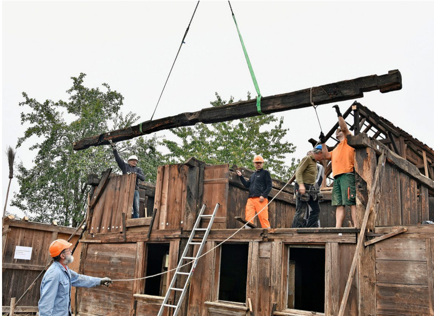
Im August 2019 wurde das Taunerhaus aus dem Jahr 1480 an der Kirchgasse 36 in Thunstetten zurückgebaut. Fotos: Thomas Peter
